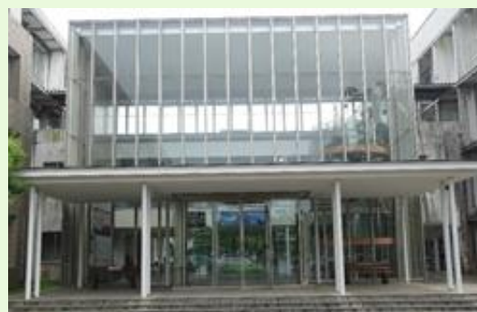
当機構が入っている総合研究棟Ⅱの正面写真 (2021年6月22日撮影)
